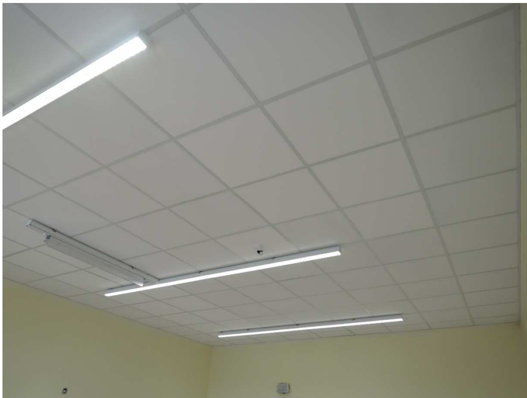
Obr. 5 – ukázka z realizace rastrového podhledu.
